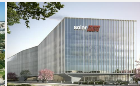
רמת השרון SolarEdge
